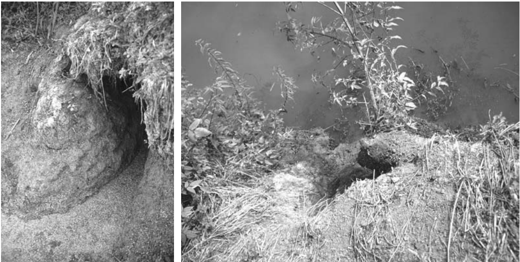
Figura 4.5. Ingresso di tana scavato in un argine (a sinistra). Esempio di argine eroso dal continuo passaggio (a destra).
